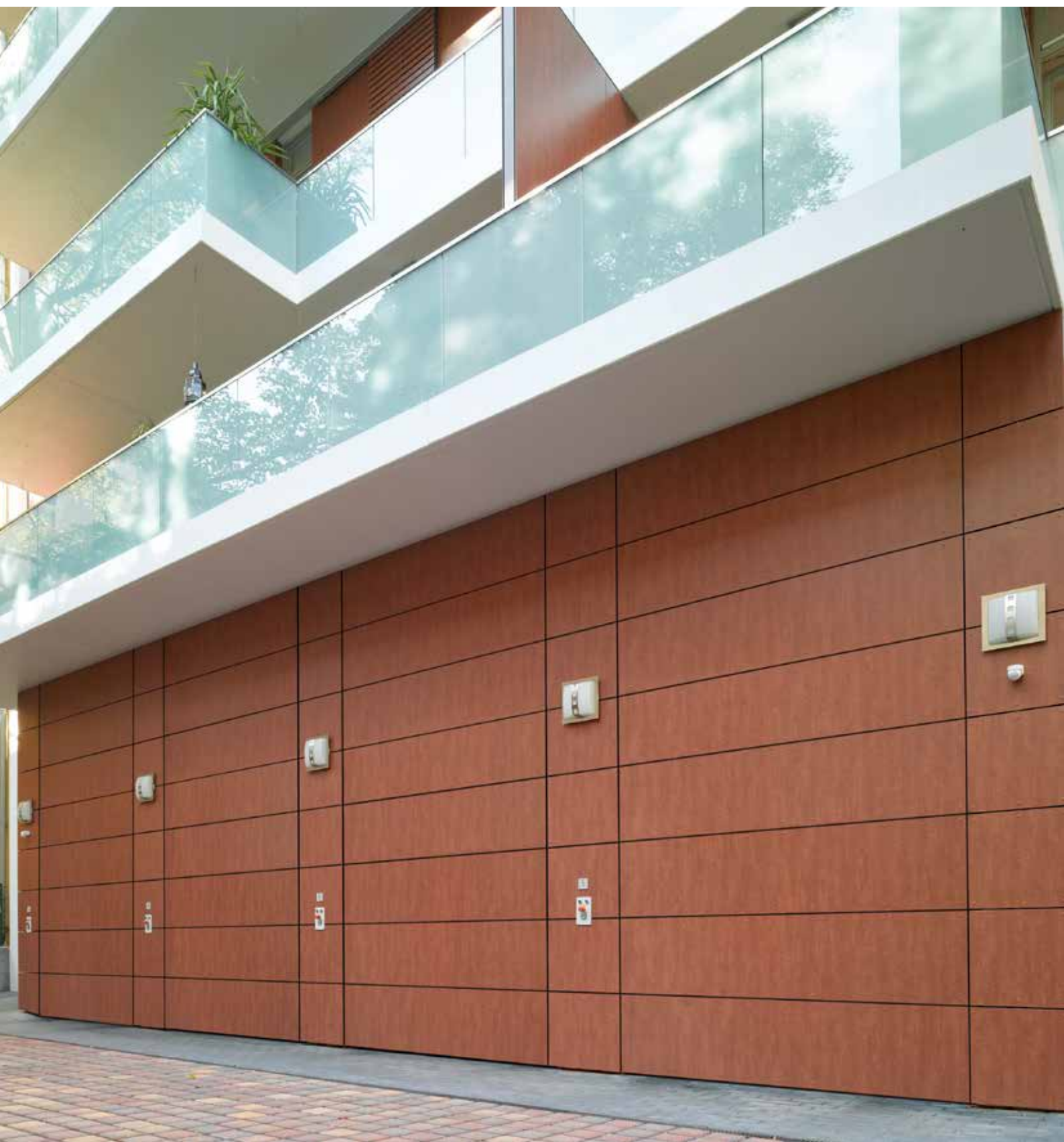
Opláštění dle požadavků zákazníka vrstevnými dřevěnými deskami
